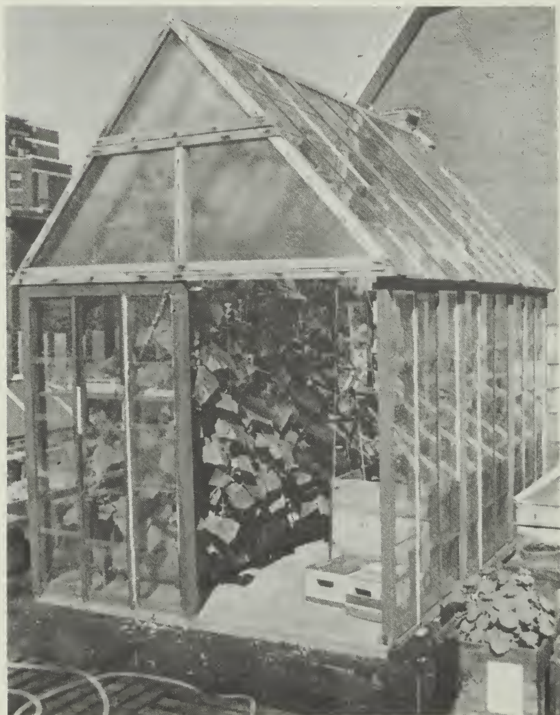
Figure 2. Serre assemblée à l'aide de vieilles fenêtres
